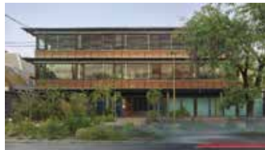
CONJUNTO BURGOS NET ZERO Las Condes, RM Arquitecto: Cristián Izquierdo L. Conjunto de viviendas y oficinas. Primer edificio latinoamericano carbono neutral. Estructura de madera laminada.
