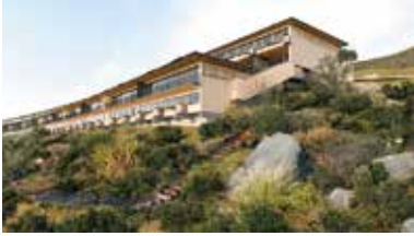
EL ZORRO CONDOMINIO PARQUE Lo Barnechea, RM Arquitecto: Cristián Izquierdo L. Conjunto residencial en un terreno de 5 ha con gran parque de restitución ecológica. Diseño, bienestar y respeto por el entorno.
