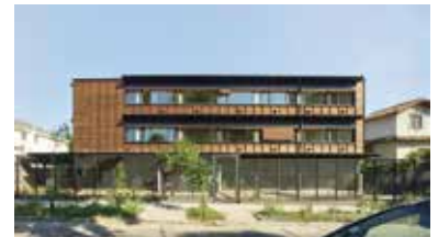
CONJUNTO RUPERTO CORREA Providencia, RM Arquitecto: Cristián Izquierdo L. Casas y depts. Una de las primeras obras residenciales de 3 pisos en Chile con estructura de madera laminada.
